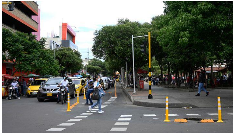
Figura. Infraestructura vial para los bici usuarios
